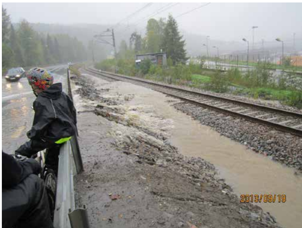
Figur 29: Översvämning av riksväg 90 och järnväg vid Väja den 19 september 2013. Foto: Kramfors kommun.
