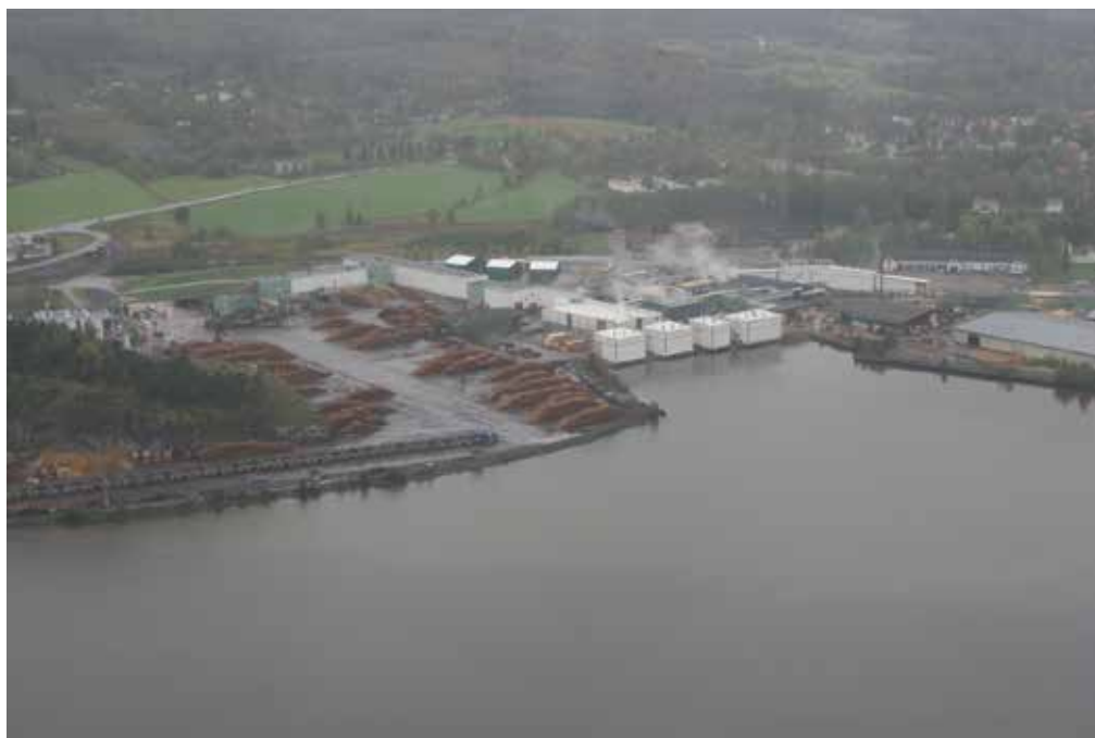
Figur 36: Högt vattenstånd vid Bollstasågen. Foto: Kramfors kommun
